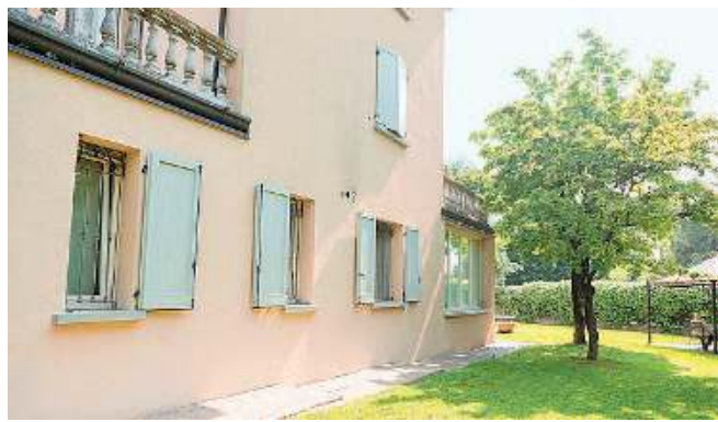
A Gottolengo. La Cassa Padana ha fatto ristrutturare l'edificio
